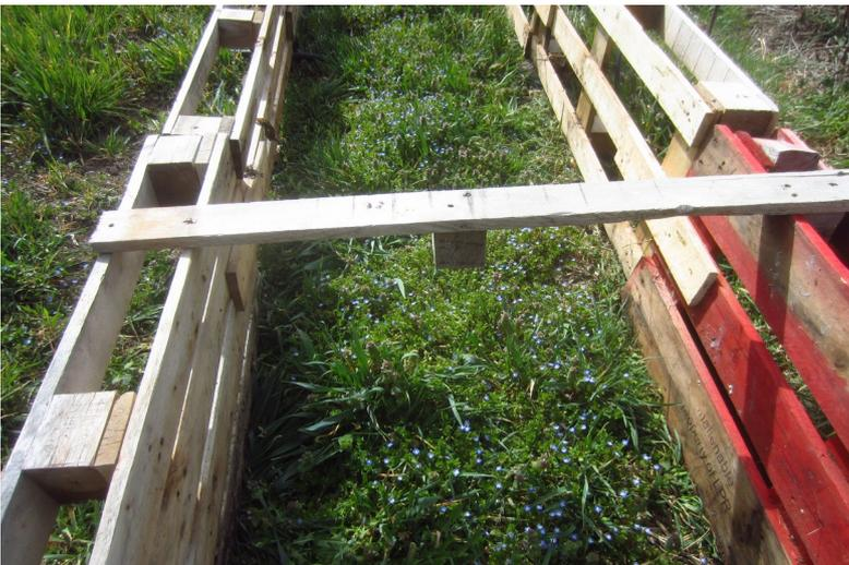
3- Selon la taille de la structure, il peut être nécessaire d'ajouter des renforts entre les deux cotés.
