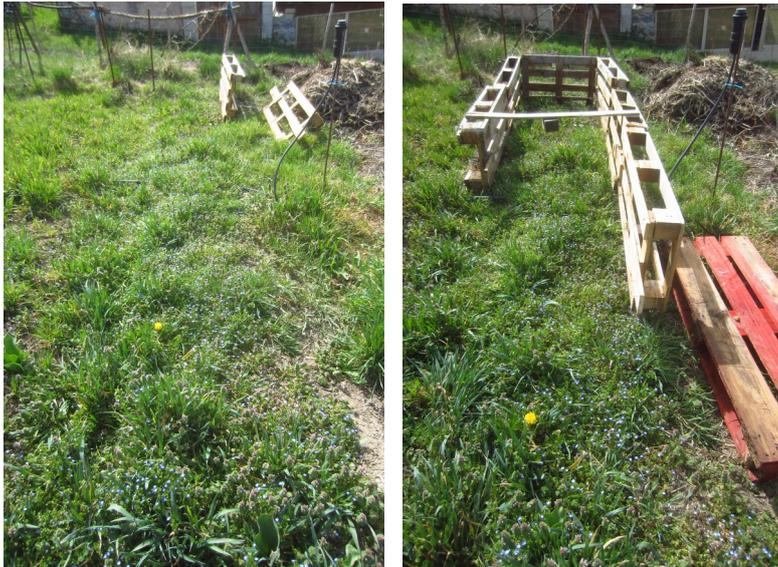
1- Réalisation du coffrage. Il est possible d'utiliser des palettes coupées en deux dans la longueur. On obtient ainsi un coffrage d'environ 40 cm de hauteur.
